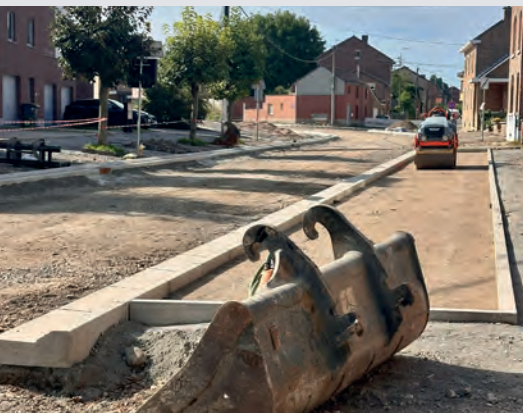
Les travaux de la rue Louis Maréchal , devant la crèche, suivent leur cours.
