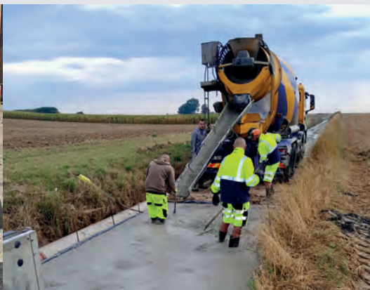
Réparations dans un chemin de remembrement
