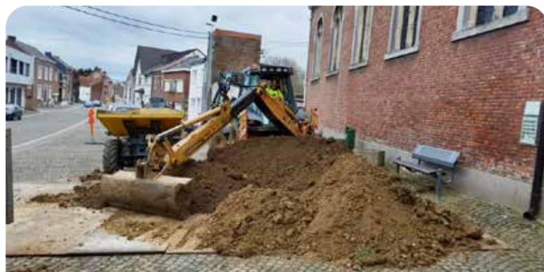
Travaux de préparation du sol en vue de faire pousser de l'herbe Église d'Oreye (rue des Combattants)
