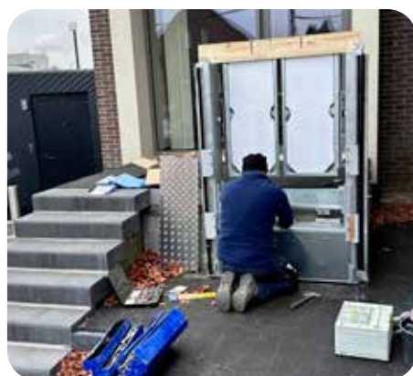
Installation de l'élévateur PMR Oreye Médical
